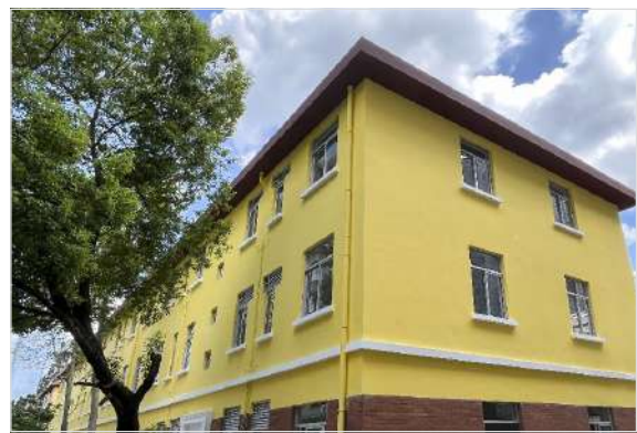
奥宝公司、鹰金钱公司参与员村四横路 5 号大院楼栋重建工作
