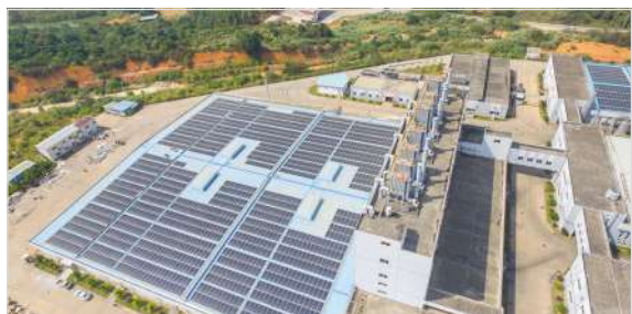
虎头公司光伏车间
